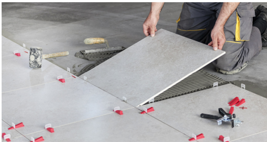
Figura 07 – Assentamento de piso cerâmico. Fonte: Embramarco.
