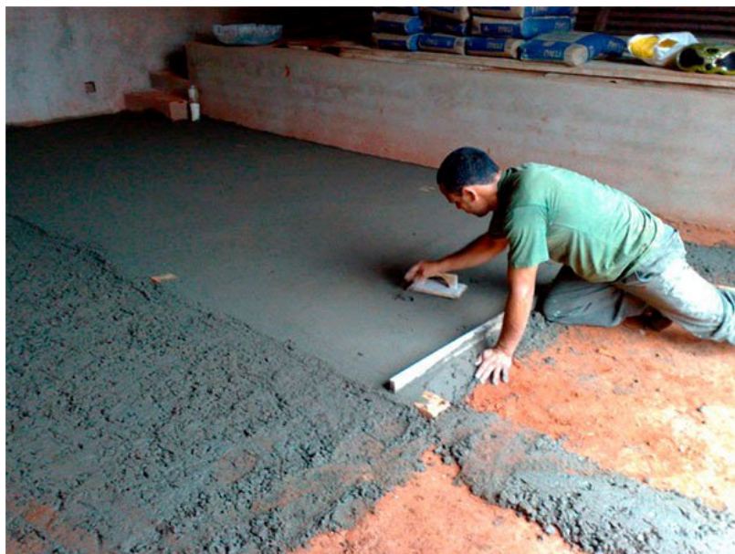
Figura 06 – Execução de contrapiso. Fonte: Portal Metálica.
